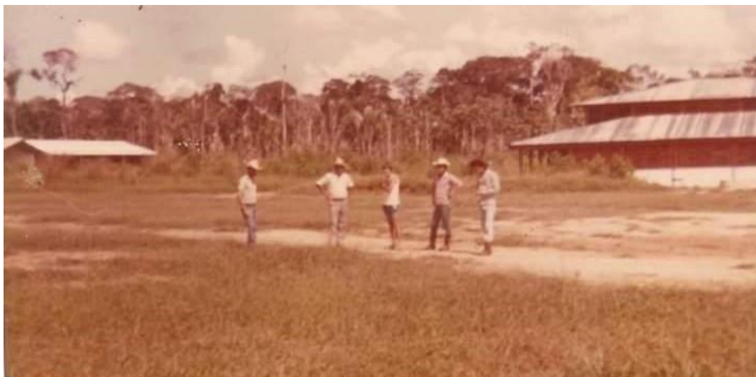
Figura 1. Construção do Centro Administrativo Municipal (1984).
