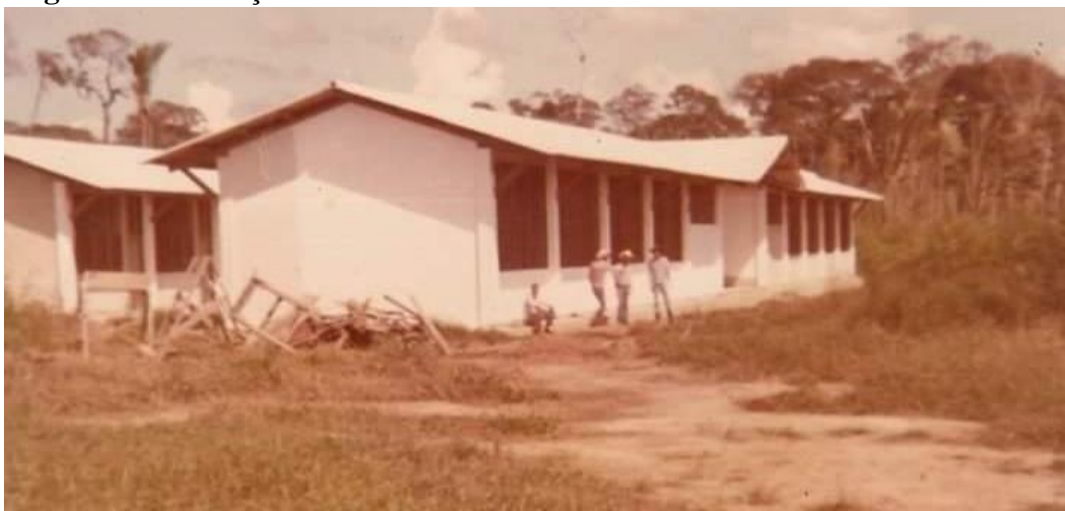
Figura 3. Construção da Escola Estadual Tubarão
