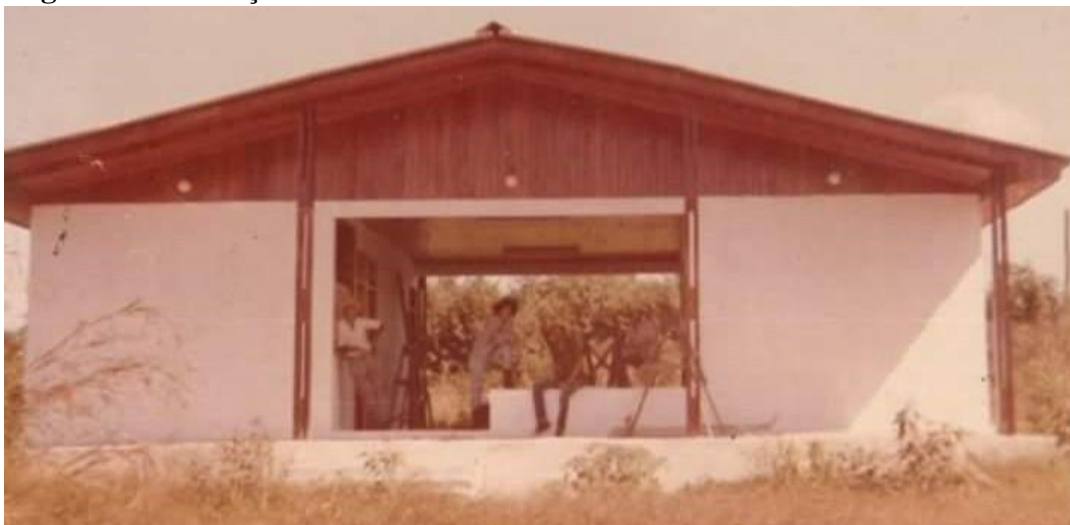
Figura 2. Construção da Unidade Básica de Saúde.
