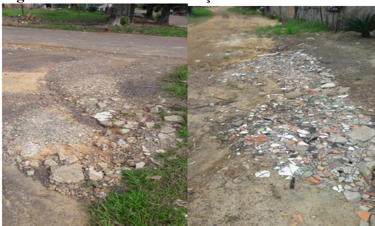
Figura 25. Resíduos de construção civil reutilizados.
